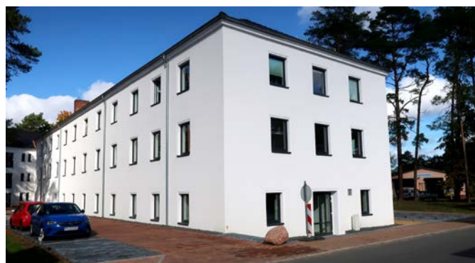
Der neue Standort für das Team Geschäftsstelle und den Bereich Erste Hilfe / Bildung
